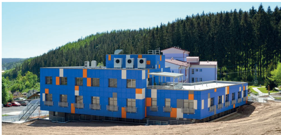
Nová budova hospicové péče Rehos - 2. místo za nejlepší stavbu v hodnocení odborné poroty.
